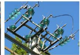
Drone au service des isolateurs verre (photo drone Alérion)
